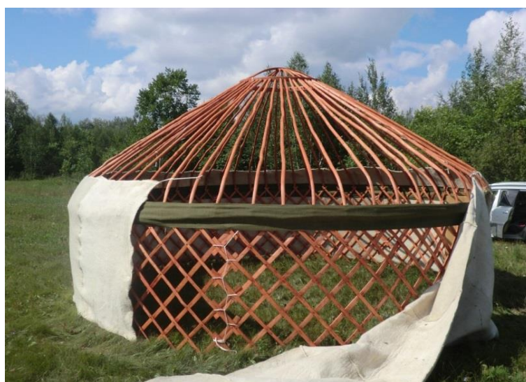
Рис. 5. Утепление юрт
