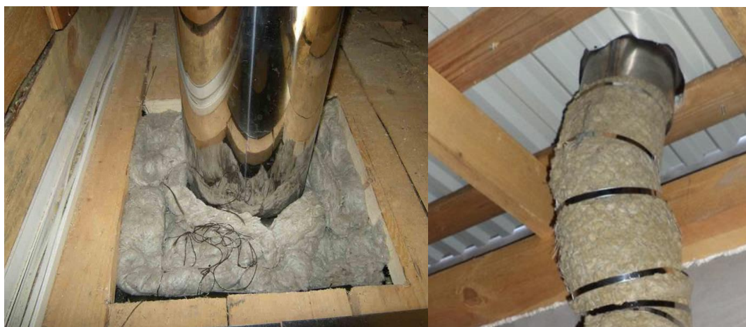
Рис. 4. Утепление дымоходных труб
