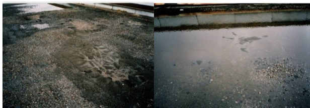
Рис. 1. Фрагмент кровли с дефектами
