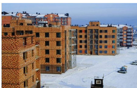
Рис. 1. Несущие кирпичные стены с пустотными плитами перекрытия
