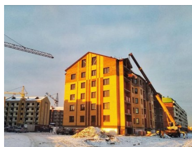
Рис. 1. Несущие кирпичные стены с пустотными плитами перекрытия
